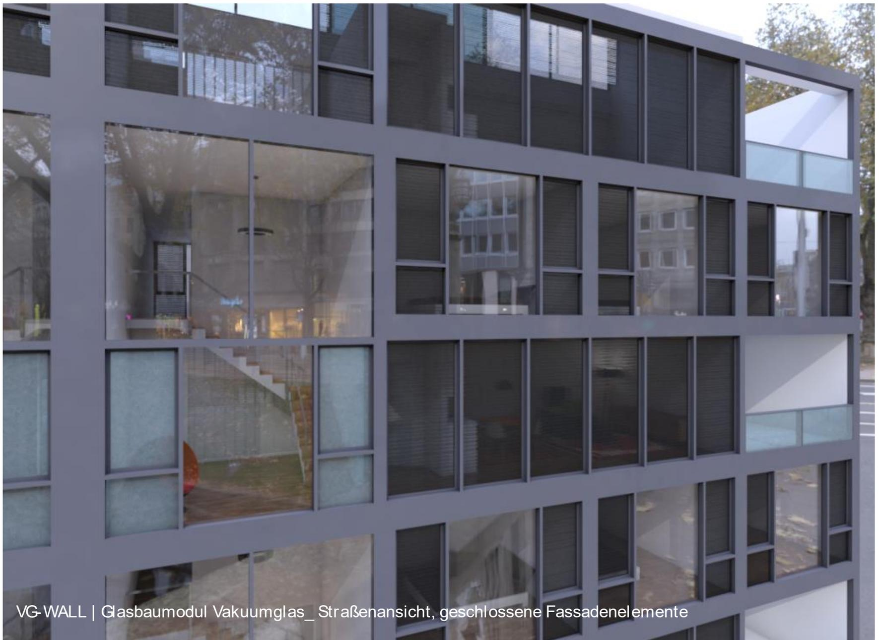
VG-WALL | Glasbaumodul Vakuumglas\_ Straßenansicht, geschlossene Fassadenelemente
