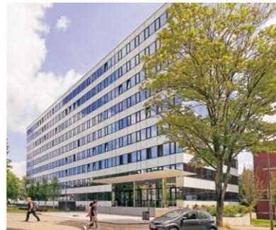
Der in den 1960er-Jahren errichtete Sammelbau Maschinenwesen der RWTH wurde bis auf die Stahlbetonkonstruktion entkernt und erstrahlt heute energieeffizient in neuem Glanz.
