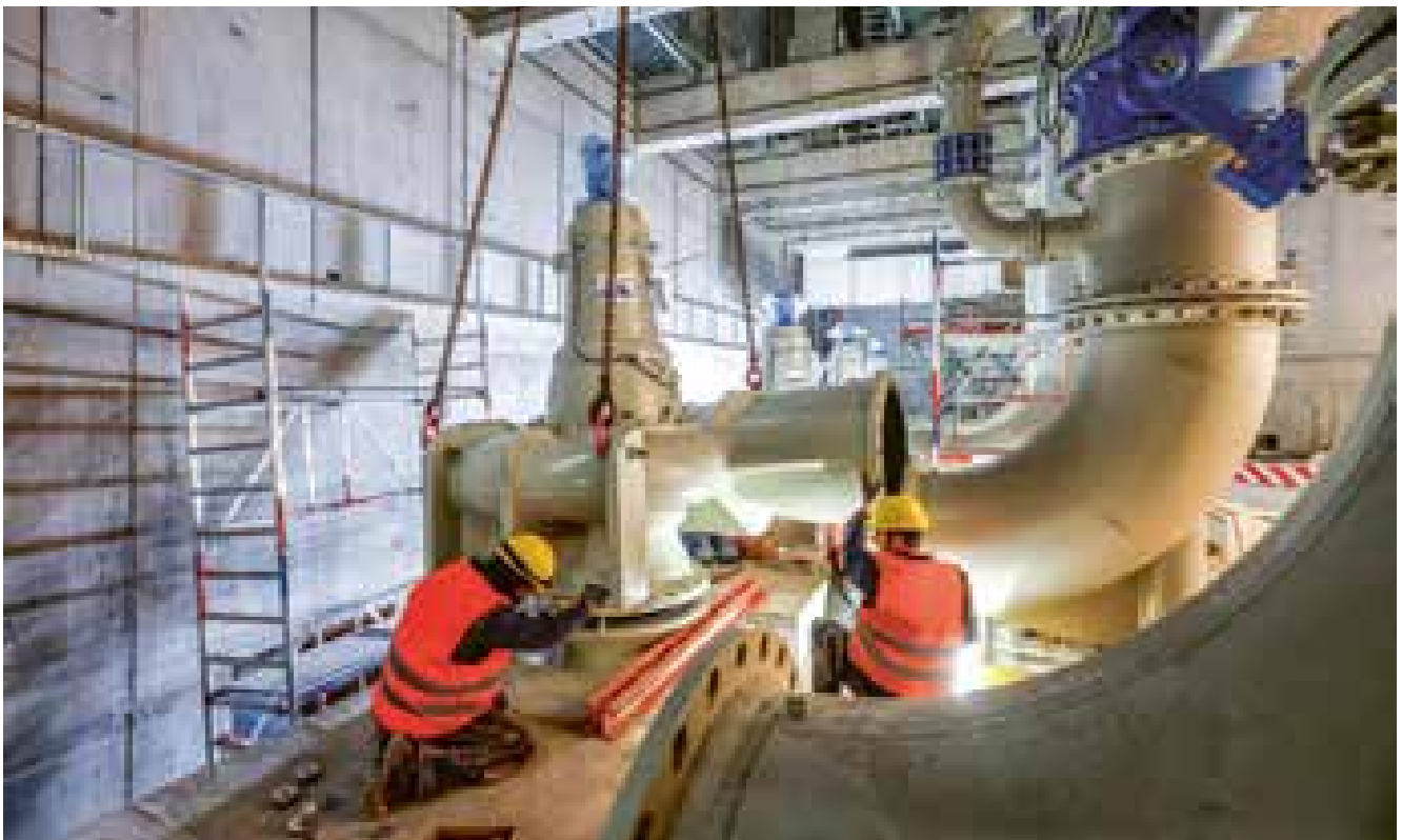
Pumpwerk Oberhausen Februar 2020: Einheben der Pumpen, die in Zukunft 16.000 Liter Abwasser pro Minute fördern.
