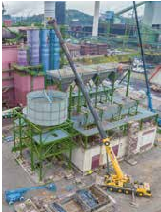
Oktober 2019: Bau einer der weltweit größten und effektivsten Tuchfilteranlagen am thyssenkrupp Standort Duisburg.
