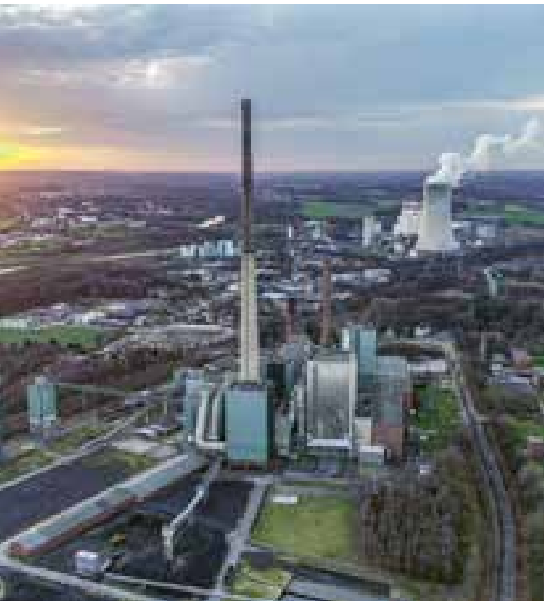
Großflächiges Konversionsprojekt: Im Juni 2020 begann der Rückbau des ehemaligen STEAG Steinkohlekraftwerks in Lünen (Kreis Unna).
