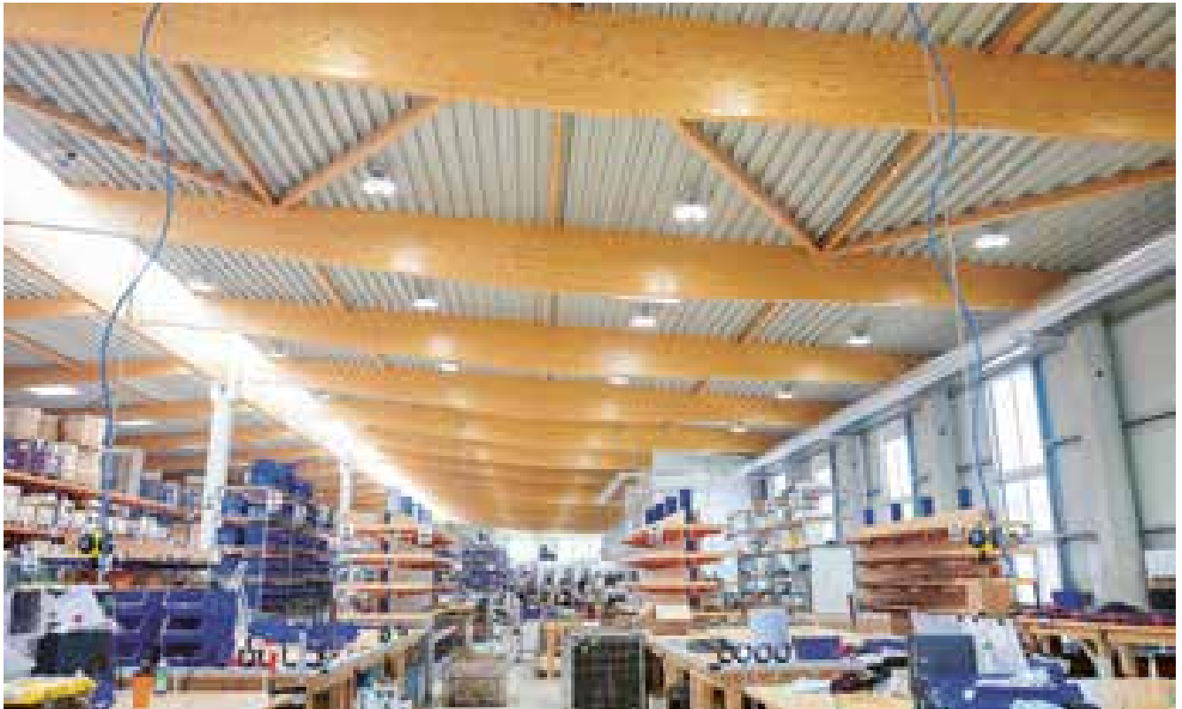
Zu 80 % autark: Das Energiekonzept der Becker GmbH – Robot Equipment Automotive Dülmen kombiniert Photovoltaik, Batteriespeicher und Wärmepumpe.
